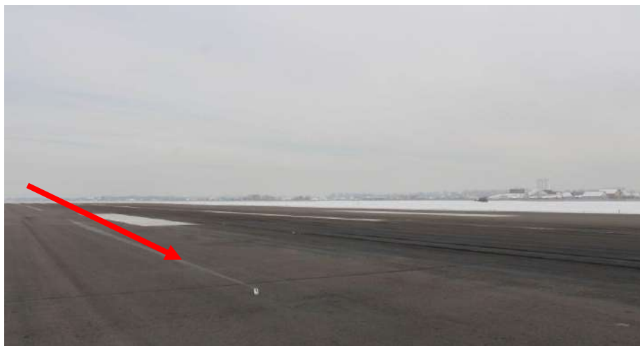
Рис. 6. Следы касания законцовкой левого крыла поверхности ВПП
