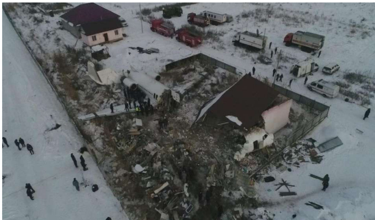
Рис. 11. Разрушенные фрагменты ВС Fokker-100 после удара о строение
