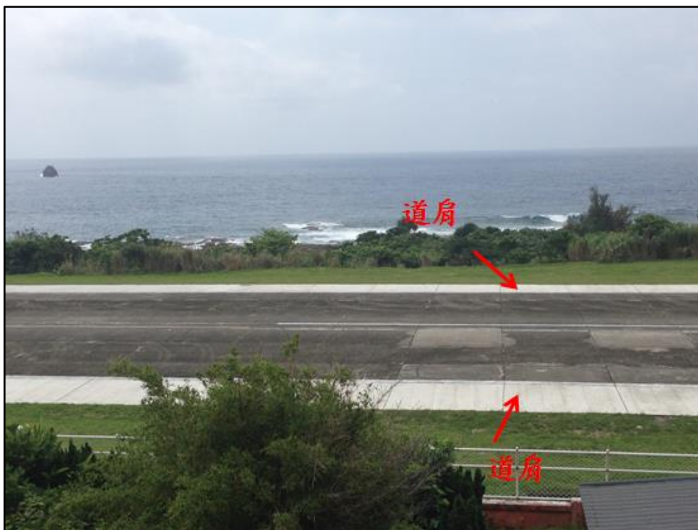
圖 1.10-2 蘭嶼機場跑道水泥混凝土道肩
