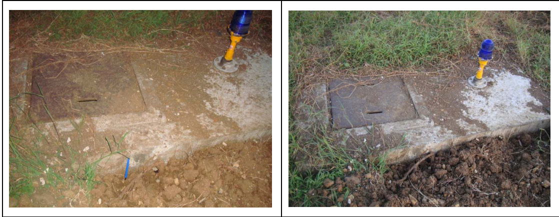
圖 1.10-10 編號 A 孔座水泥結構與滑行道邊燈圖
