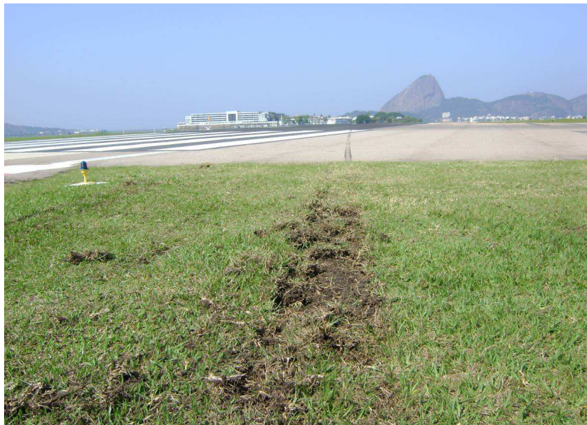
Figura 02: Marcas de derrapagem no final da cabeceira 20L.
