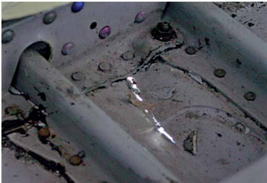
Fessura nella lamiera.
